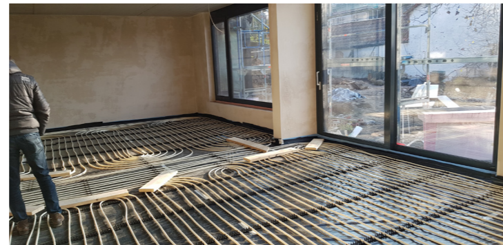
Abb. 16: Einbau einer Fußbodenheizung
