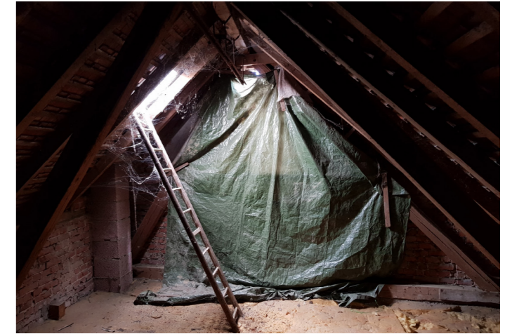
Abb. 5: Ausbaupotential im Dachraum
