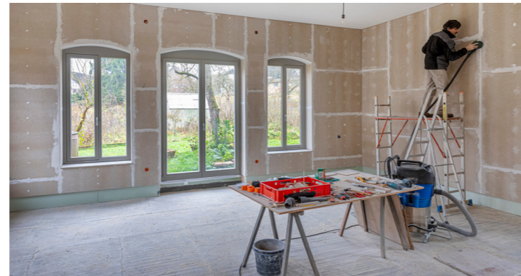
Abb. 10: Innendämmung mit Holzplatten
