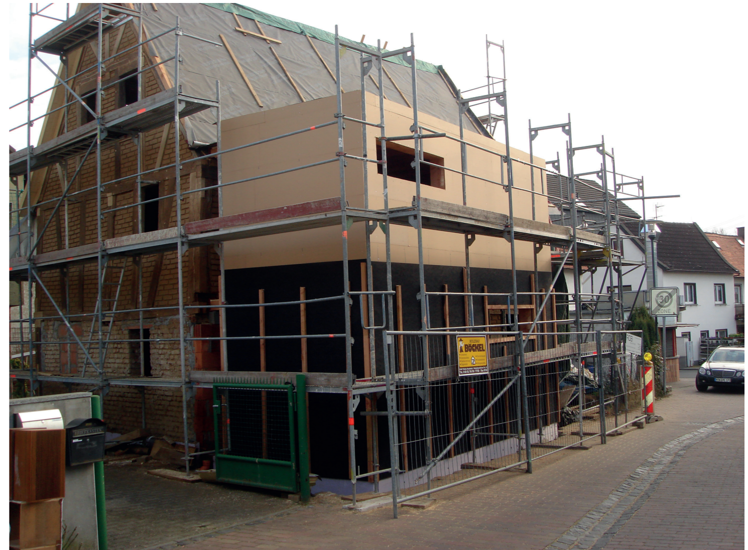
Abb. 15: Anbau an einem historischen Fachwerkhaus
