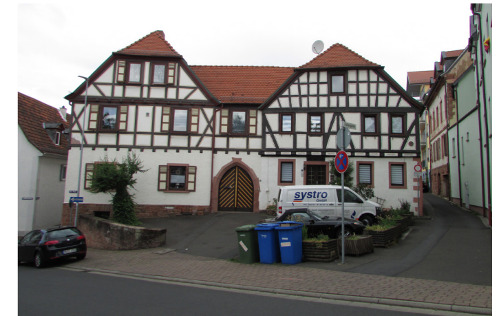
Abb. 3: Fachwerkfassade Am Platz
